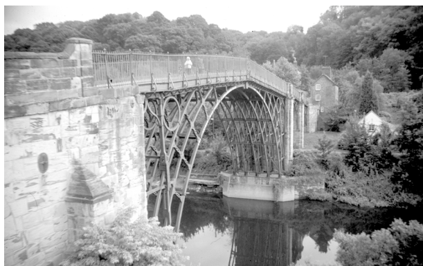
El puente de hierro fundido de Ironbridge
