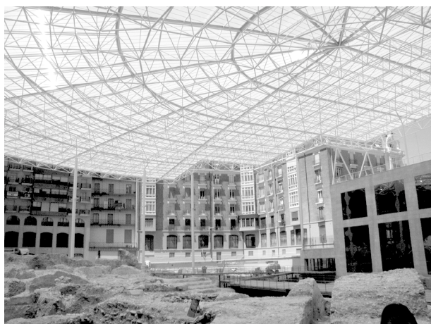
Estructura de protección de los restos del teatro romano de Zaragoza
