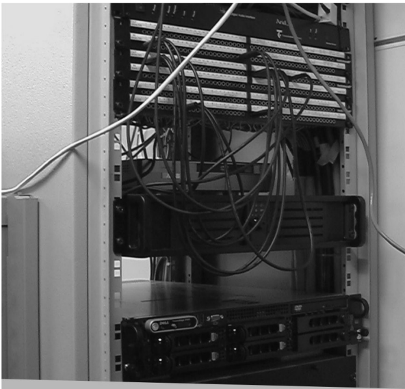
Un estudio analógico – los dispositivos están conectados mediante cables.
